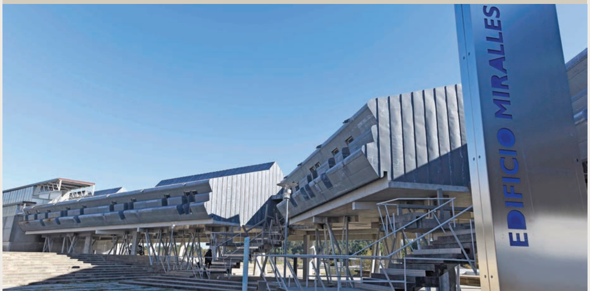
Vista parcial do Edificio Miralles, sede do Consello Social no campus de Vigo
