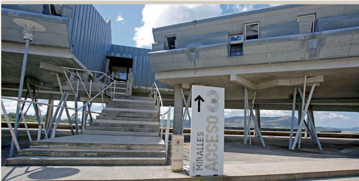
Vista Edificio Miralles, que acolle a sede do Consello Social. (Campus de Vigo)
