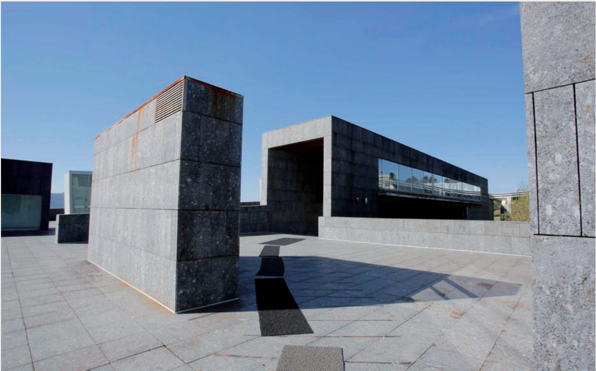
4. Aspecto da singular e premiada arquitectura do Campus. 5. Imaxe da parte traseira do Edificio Miralles, no que se ubica o Consello Social. 6. Volumes singulares nos accesos á biblioteca.
